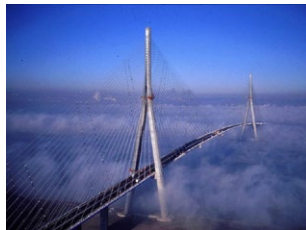
Pont de Normandie, France
